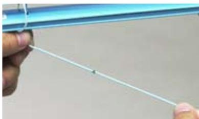
**5** 操作側から新しい昇降コードが出てくるまで古い昇降コードを静かにゆっくりと引き出してください。新しい昇降コードはストッパーの部分から約25cmほど長くなる程度に引出してください。引出し終わりましたら、溶着部分をはさみでカットしてください。
