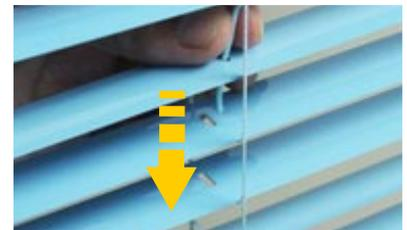
**11** ボトムレールの穴に昇降コードを通しましたら、コードの先端に結び目を作ってください。
