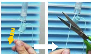
**6** ボトムレール側の昇降コードをカットして結び目を作り、ボトムレールの中に押し込んでください。
