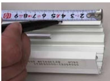
**4** 金ノコでハンガーレールを切断してください。切断後はヤスリで切断面を整えてください。
