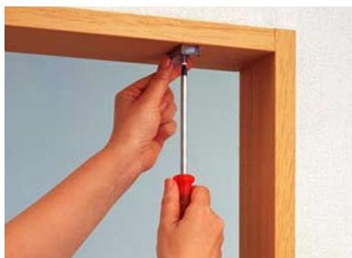
ハンガーレールが水平になるよう注意しながら、レールの端から 60～80mm 内側に取付けブラケットをビスで固定してください。
